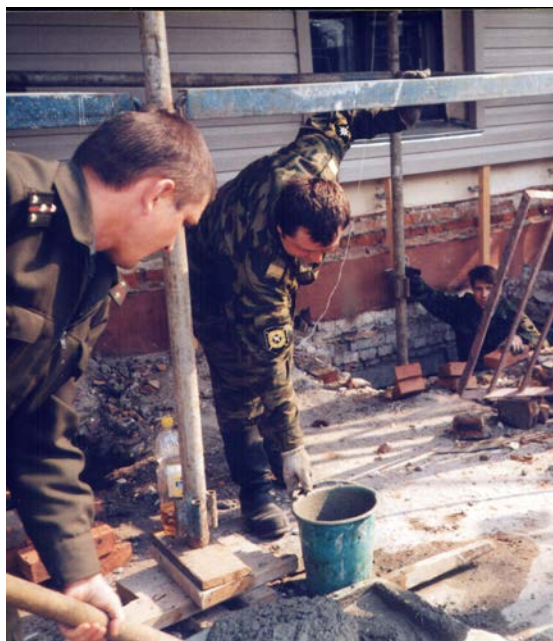
Зам. начальника части Гилунов Д.Н., начальник подразделения Троценко П.А. на личном примере организуют работу по ремонту пожарной части.
